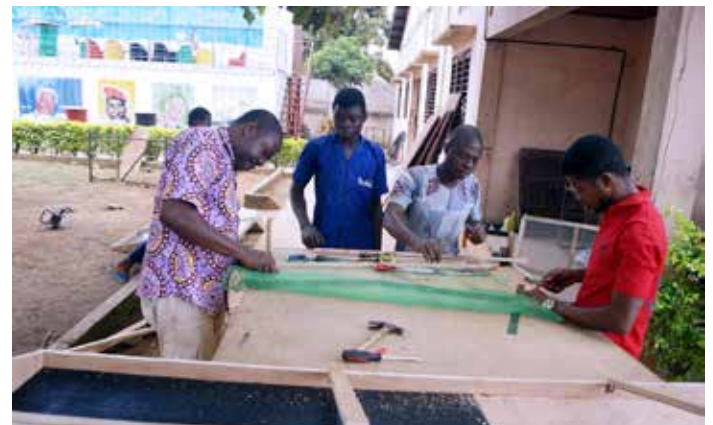
Bau der Anlage zur Fruchttrocknung
